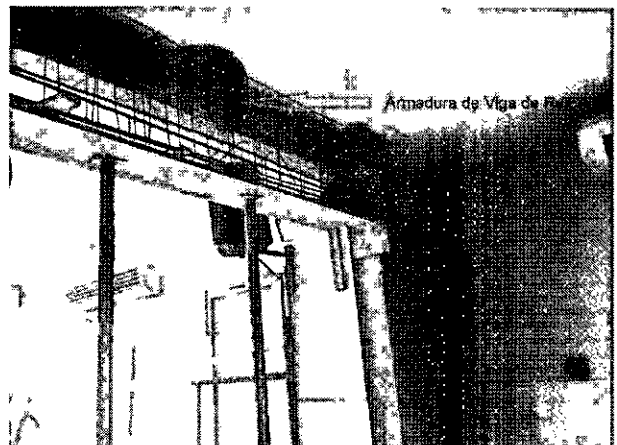
ARMADURA DE VIGA DE REFORÇO
